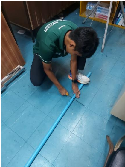
ตัดท่อ PVC ให้ได้ขนาดที่ต้องการ
