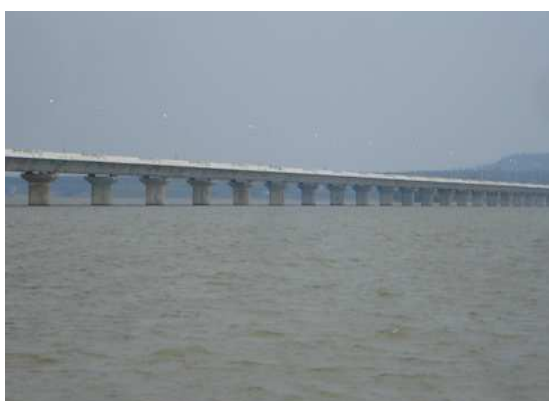
ภาพประกอบ 3 ระบบนิเวศเขตกลางน้ำของเขื่อนลำปาว บริเวณสะพานเทพสุตา
