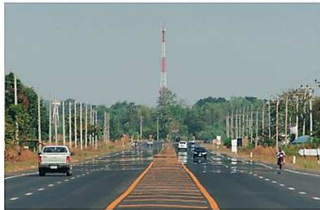
รูปที่ 10 มิราจที่ทำให้เห็นน้ำบนพื้นถนนแห้ง
