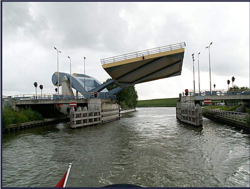
ยังอยู่ในดินแดงกังหันลม ขอพาท่านไปพบกับสะพาน Balijbos Bridge
