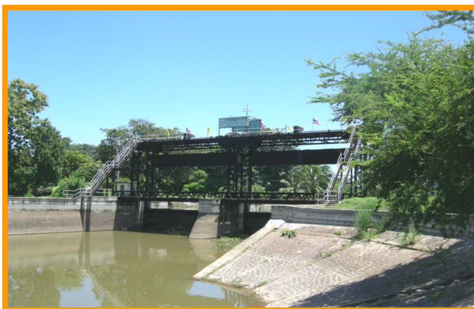
ประตูดส่งน้ำ “เขื่อนนครนายก”
