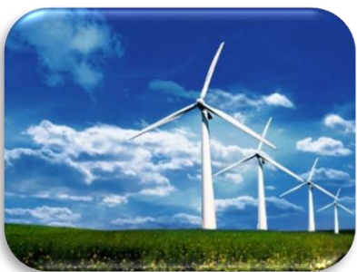
พลังงานลม ที่มา : https://tapu74.wordpress.com
